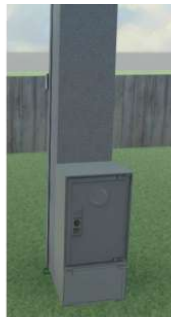
Après pose du coffret
